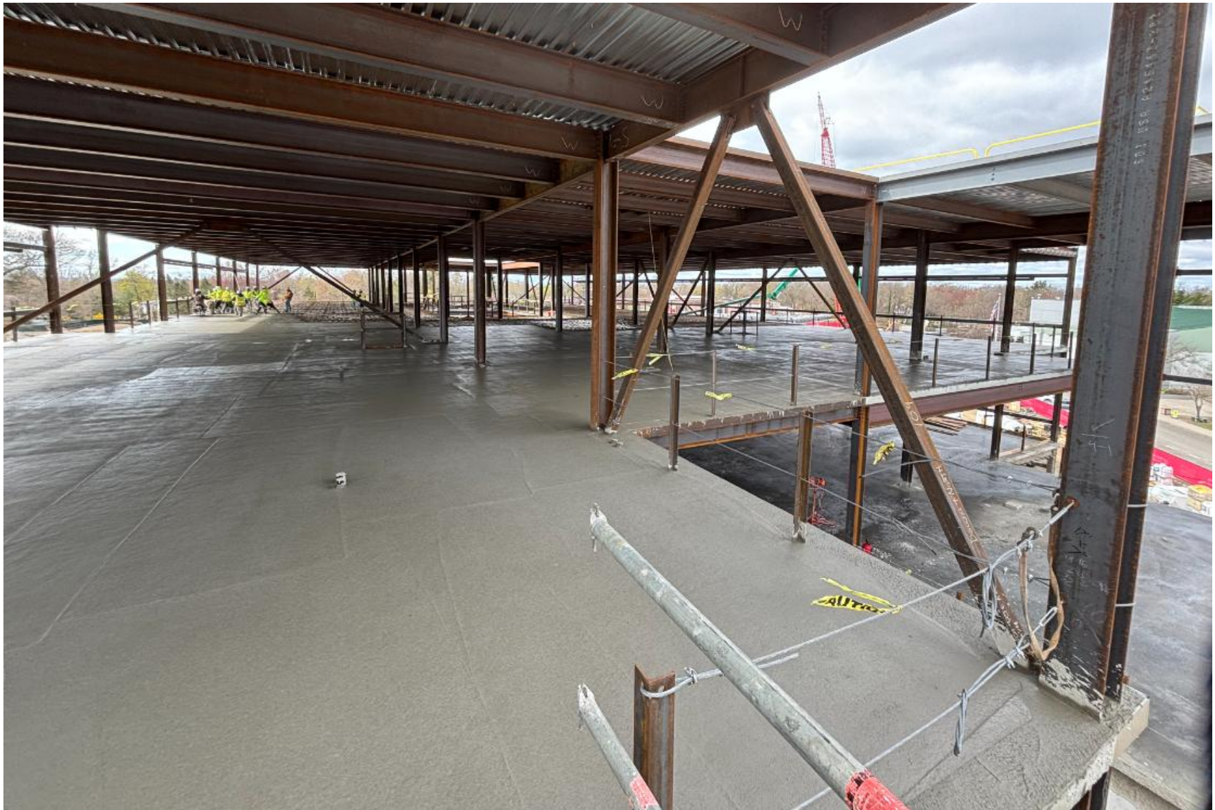
Elevated Concrete Slab Pour 4/21/25
