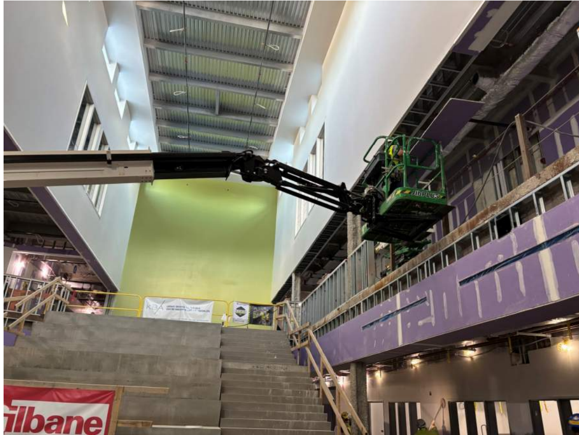
Commons Area Stair & Clerestory – 5/19/26
