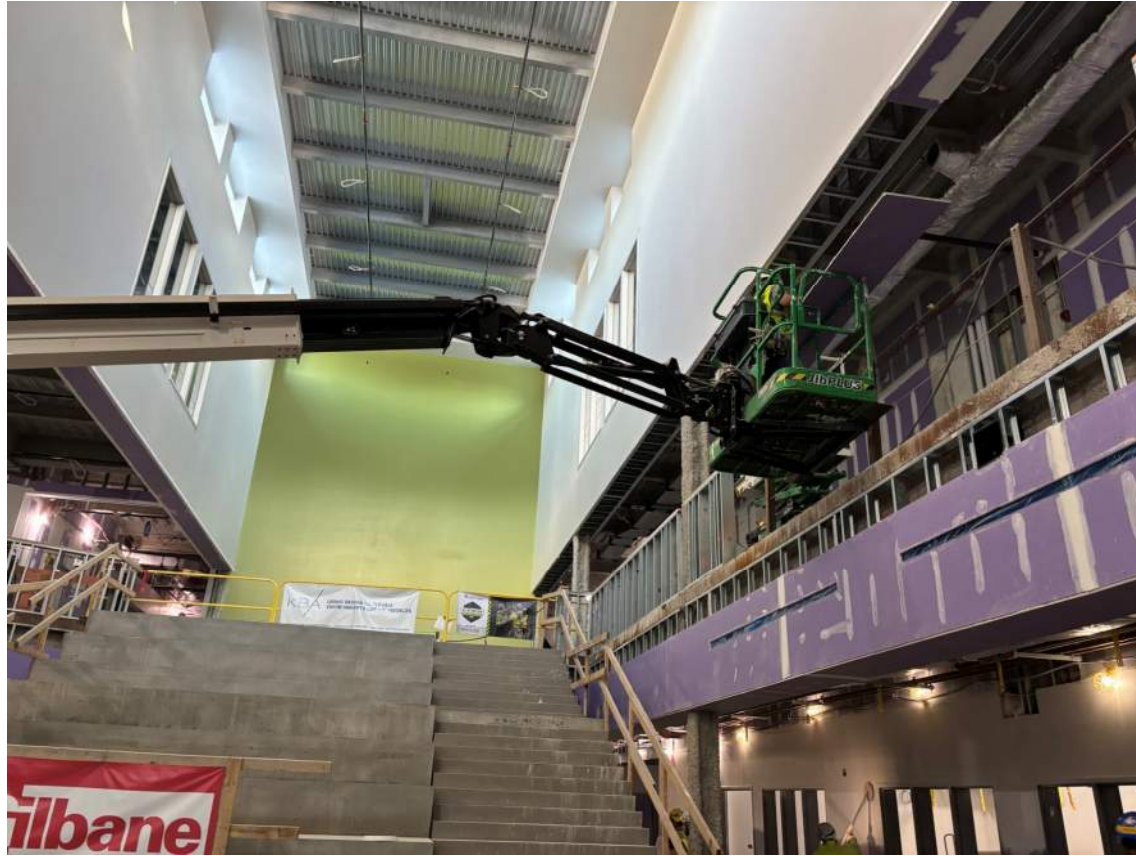
Commons Area Stair & Clerestory – 5/19/26
