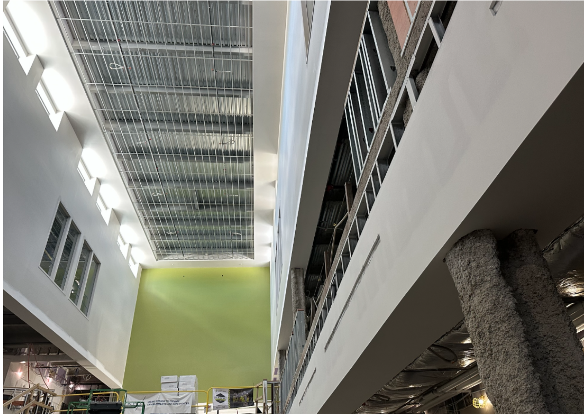
Commons Area Stair & Clerestory – 6/24/26
