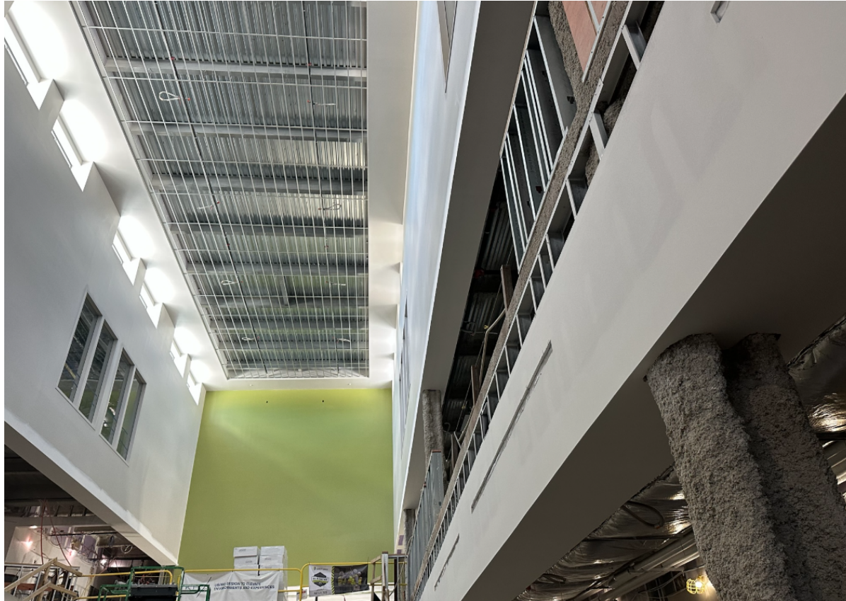
Commons Area Stair & Clerestory – 6/24/26
